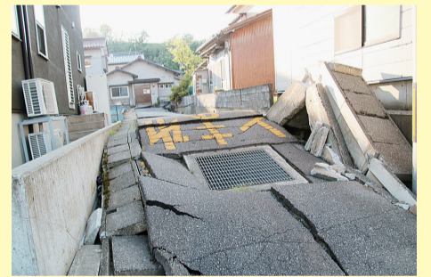
上：「忘れられた被災地」内灘地域を視察。震度5ながら、液状化と側方流動によって、多数の建物・道路が傾き、形は保つが使用できない状態。 下：半日の診療で、カルテの束がこんな感じ。
